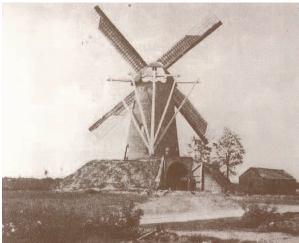
De molen aan de zuidzijde van de Gerwenseweg in Stiphout, werd in 1906 gebouwd. Na slechts dertig dienstjaren werd hij buiten werking gesteld.
